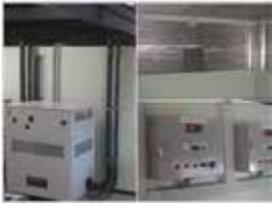
石川県の拠点になる金沢営業所へ、カノウ冷機製の無風式超低温ユニット「KNM-2222-S」を3台を導入し、10坪の超低温無風庫を新設。また既設2坪超低温庫2棟を、カノウ冷機製無風式二元ユニット「KNM-1515-S」×2台へ更新。結果、性能を-50℃から-60℃へ上げると同時に、必要動力は20馬力から8馬力になりました。性能をアップさせるとともに、大幅なコストを削減を実現しました。
